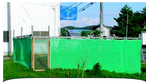
ついにこまでしてしまいました(足場の養生シートで)
