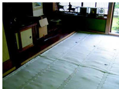
床下の処理が終わったら断熱材を厚さ 10cm で吹き込み完了
