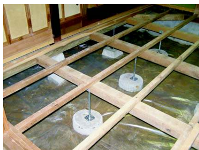
合板を除去して床を支えている木材（束）を鋼製の束に交換して土間の上に防湿シートを敷いている
