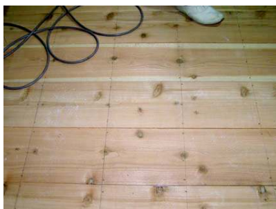
断熱材を吹き込み終了後新しい杉板（合板ではない）を張る
