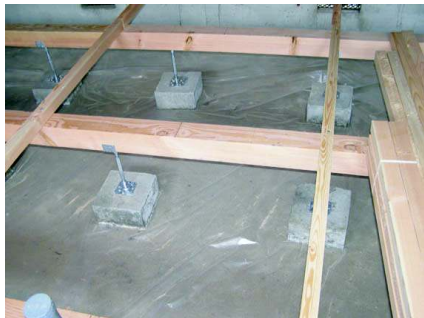
床下に防湿シートを敷き木の束から鋼製束に替え頑強にする
