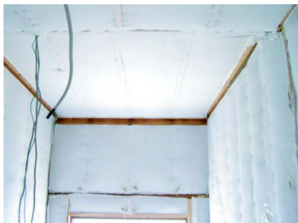
浴室天井も壁もすっぽり断熱材吹込み(脱衣室・台所も)
