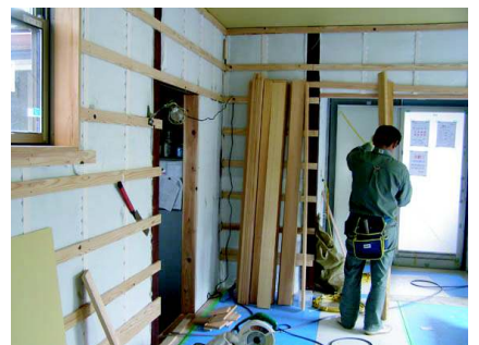
脱衣室への引き戸の木枠を取り付けている
