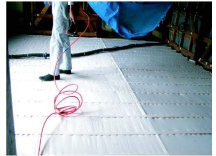
断熱材を吹き込み中(湿気を吸ったり吐いたりしてくれる自然素材のセルローズファイバー)
