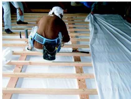
断熱材の吹込みの布を張っている
